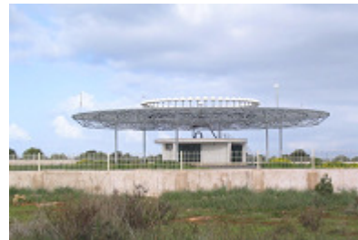
Beispiel: DVOR - Navigationsanlage
