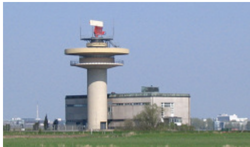
Beispiel: 2-D- Radaranlage der Flugsicherung
